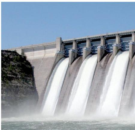
Dans une retenue d'eau, la chute d'eau du barrage libère spontanément de l'énergie : la masse d'eau, en tombant, convertit son énergie potentielle en énergie cinétique. Cette énergie peut être récupérée par une turbine.
